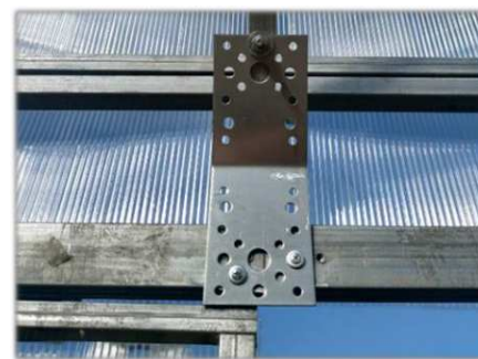
Pav. 3.4 – Viršutinės įstrižainės tvirtinimas
