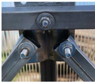
Pav. 3.2 – Šoninių įstrižainių tvirtinimas
