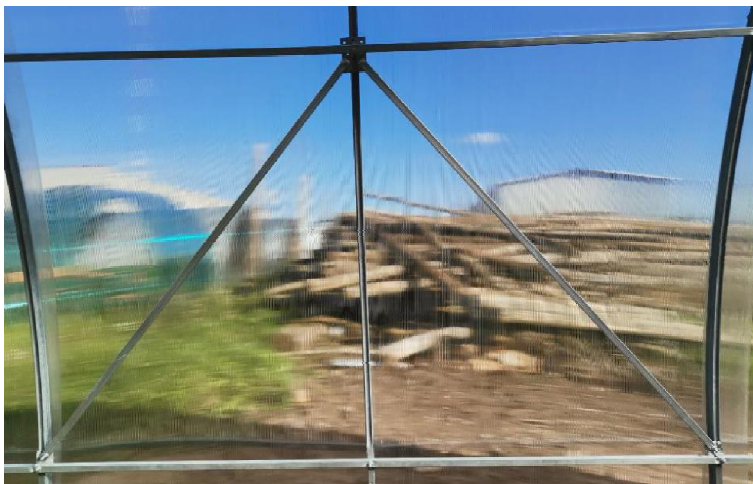
Pav. 3.3 Įstrižainių tvirtinimas
