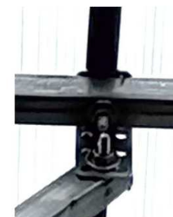
Pav. 3.4 – Viršutinės įstrižainės tvirtinimas
